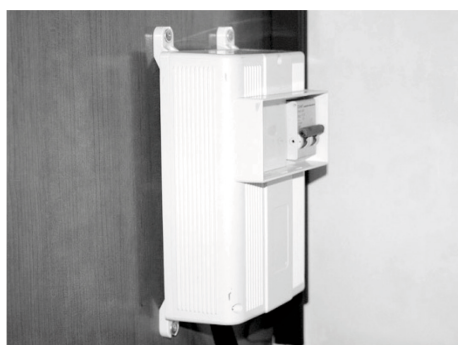
Afb. 57: Hoofdschakelaar (FI-contactverbreker)
