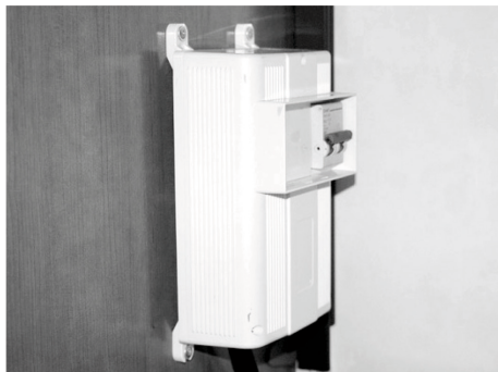
Afb. 3: Hoofdschakelaar (FI-contactverbreker)
