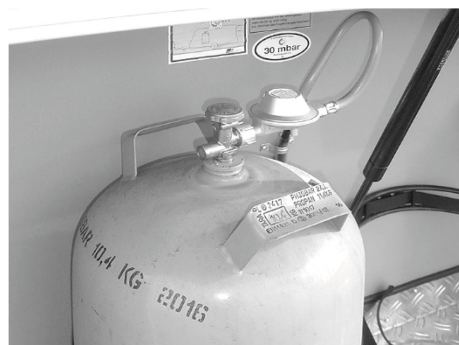
Afb. 68: Gasfles met lagedrukregelaar en lagedrukslang
