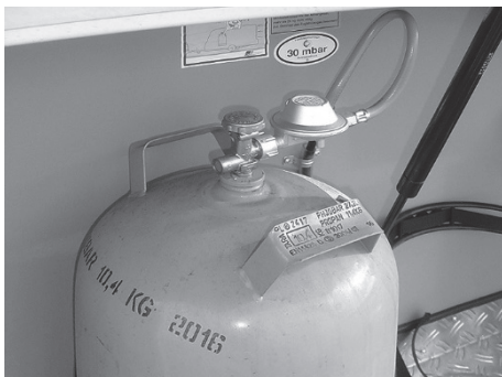
Afb. 110: Gasfles met drukverminderingsklep
