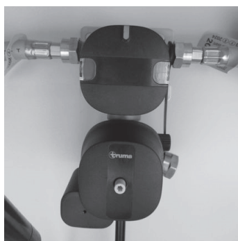
Afb. 111: Gasvoorziening DuoControl CS
