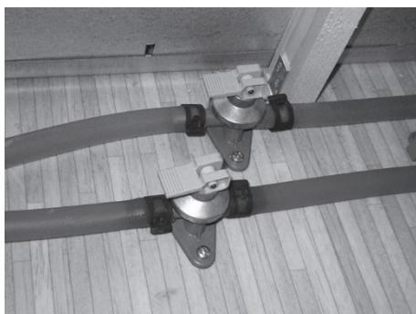
Afb. 178: Aftapkranen gesloten
