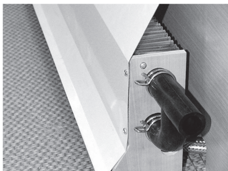
Afb. 91: Convector met warmtegeleidingplaat
